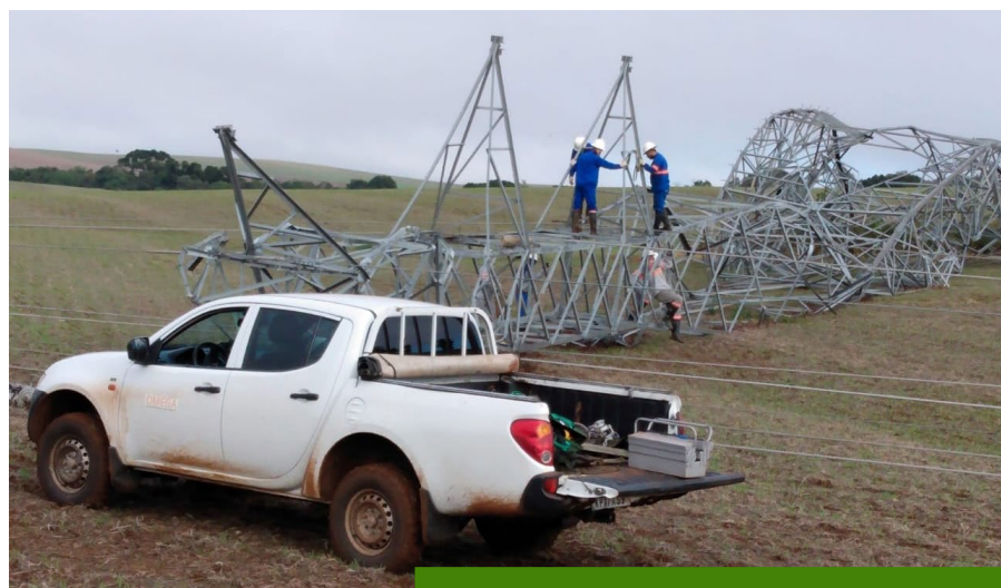
Tornado danificou estruturas de energia elétrica em Campos Novos
